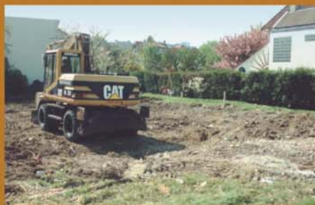
... la démolition et le déblaiement des gravas ont duré une semaine...
