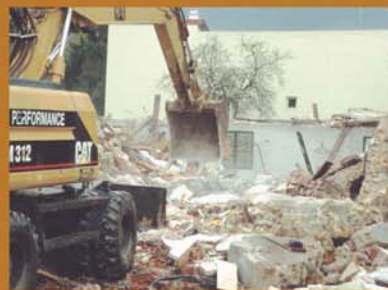
... ce qui l'a obligé à prévoir dans son budget une démolition...
