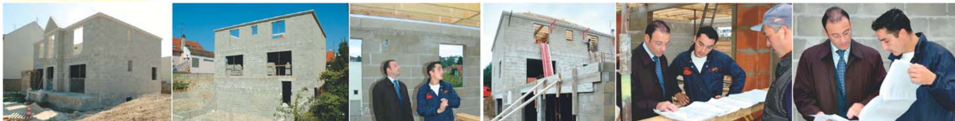
À CHAQUE ÉTAPE IMPORTANTE DE LA CONSTRUCTION, ANTHONY D. FAIT LE POINT AVEC LE RESPONSABLE DE CHANTIER ET LES ARTISANS.
