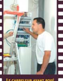
LE CARRELEUR AYANT POSÉ LES REVÊTEMENTS, L'AMÉNAGEMENT EXTÉRIEUR ÉTANT TERMINÉ... À L'ÉLECTRICIEN MAINTENANT D'INTERVENIR POUR LE RACCORDEMENT DU TABLEAU ÉLECTRIQUE.
